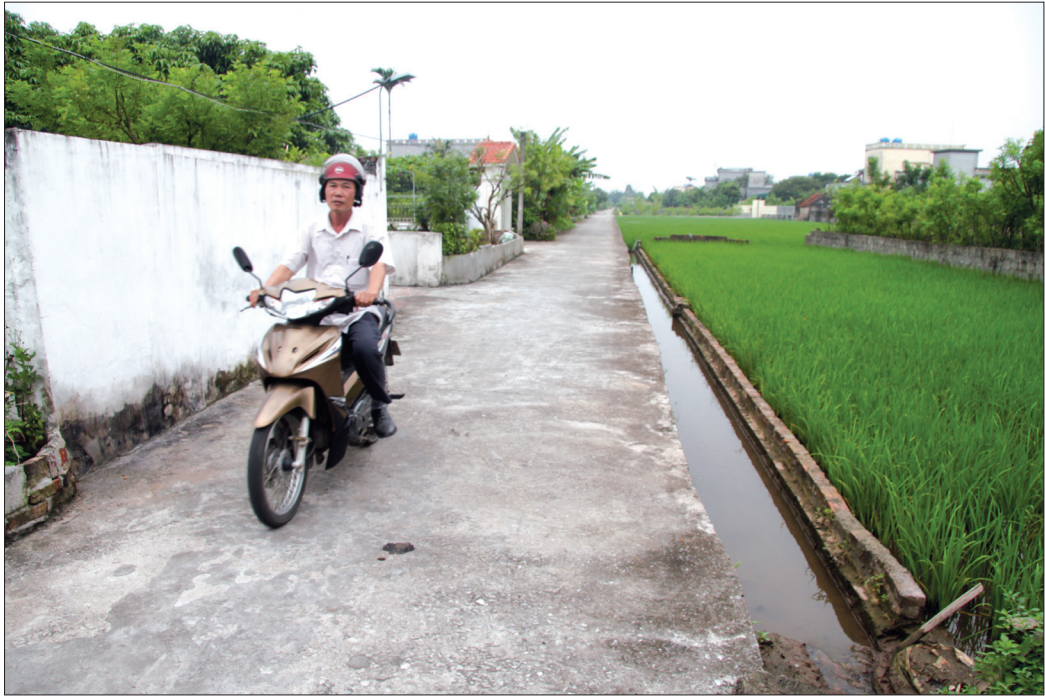
Đường giao thông nông thôn ở Đông Trà.
