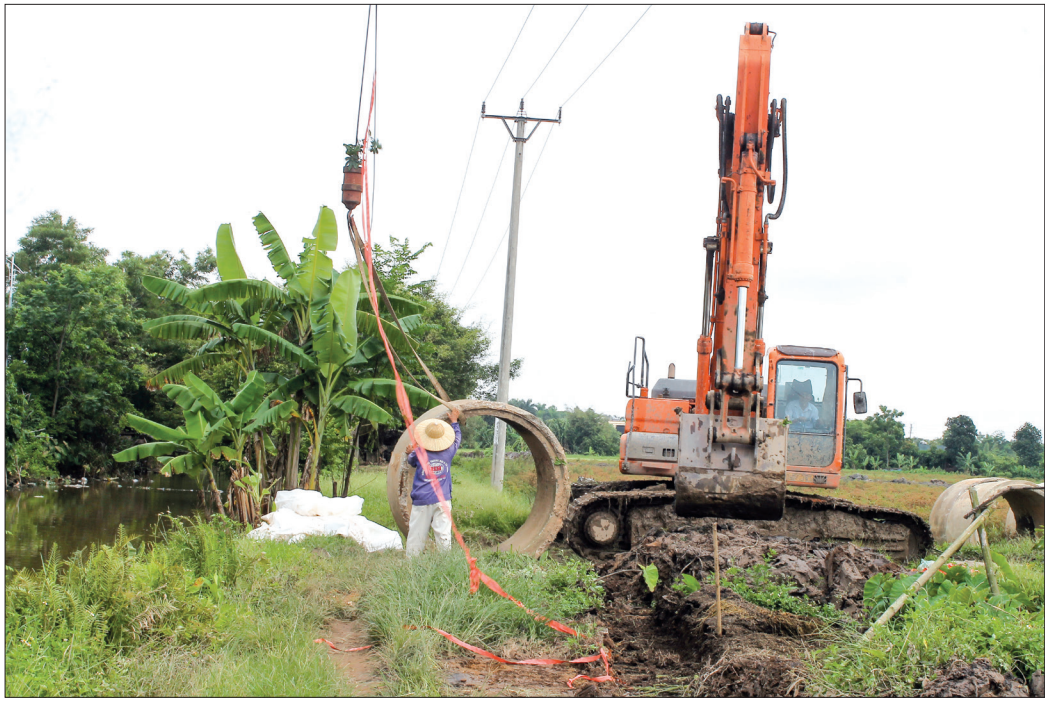
Triển khai thi công tuyến đường vành đai phía Nam thành phố Thái Bình (đoạn qua địa bàn xã Song An, huyện Vũ Thư).
