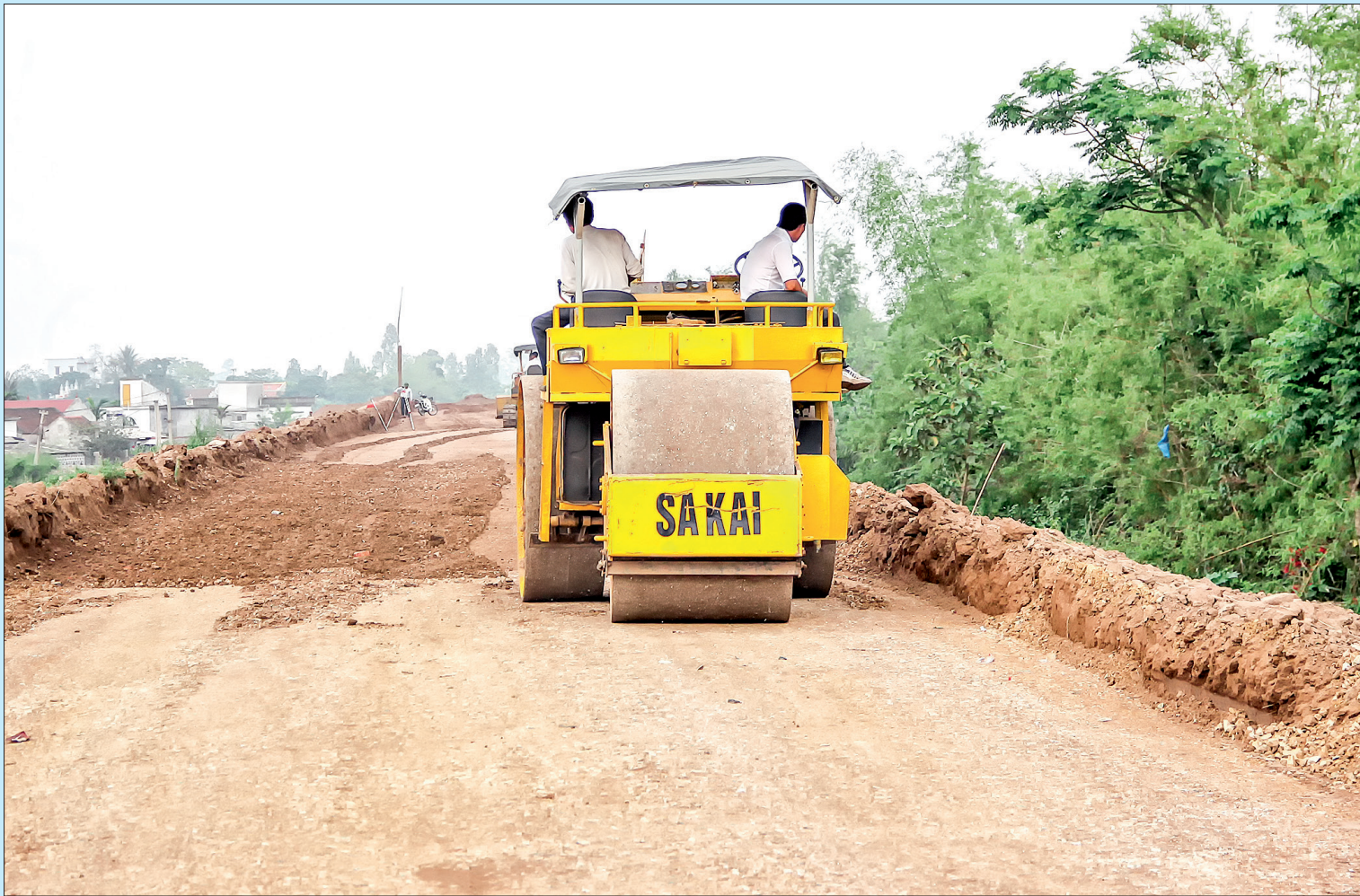
Thi công đê hữu Trà Lý, đoạn qua địa phận xã Hiệp Hòa (Vũ Thư).
