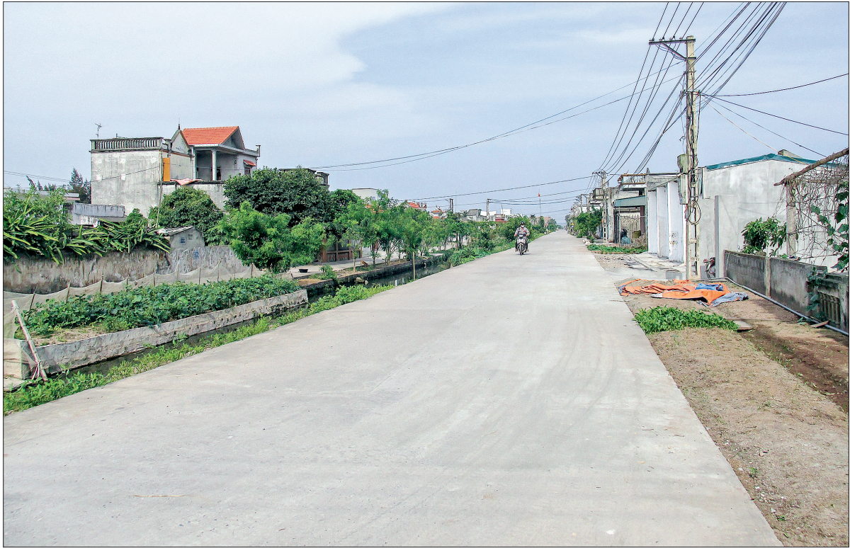
Đường giao thông nông thôn xã Đông Lâm.
