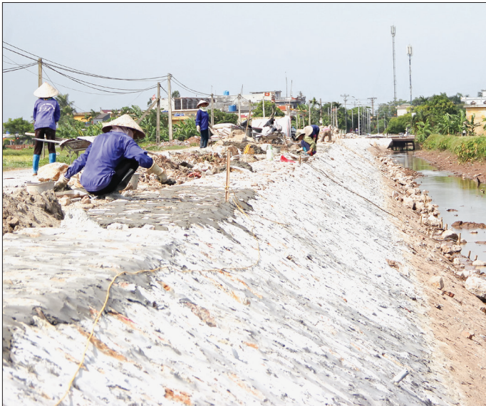
Thi công kè mái chống sạt lở đường 7 (ĐH.35) đoạn qua xã Nam Chính (Tiền Hải).
