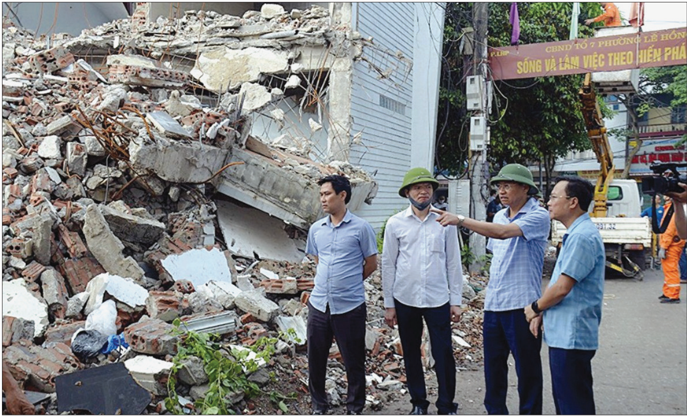
Lãnh đạo thành phố chỉ đạo công tác giải phóng mặt bằng dự án.
