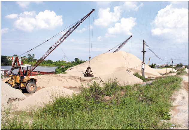
Một số bãi tập kết vật liệu xây dựng trái phép nằm trong hành lang bảo vệ đê trên tuyến đê hữu Trà Lý, đoạn qua địa phận phường Tiến Phong (thành phố Thái Bình).
