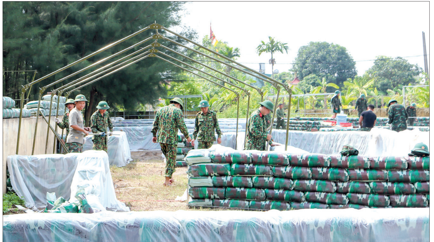
Thi công bệnh viện dã chiến phục vụ diễn tập khu vực phòng thủ tỉnh.
