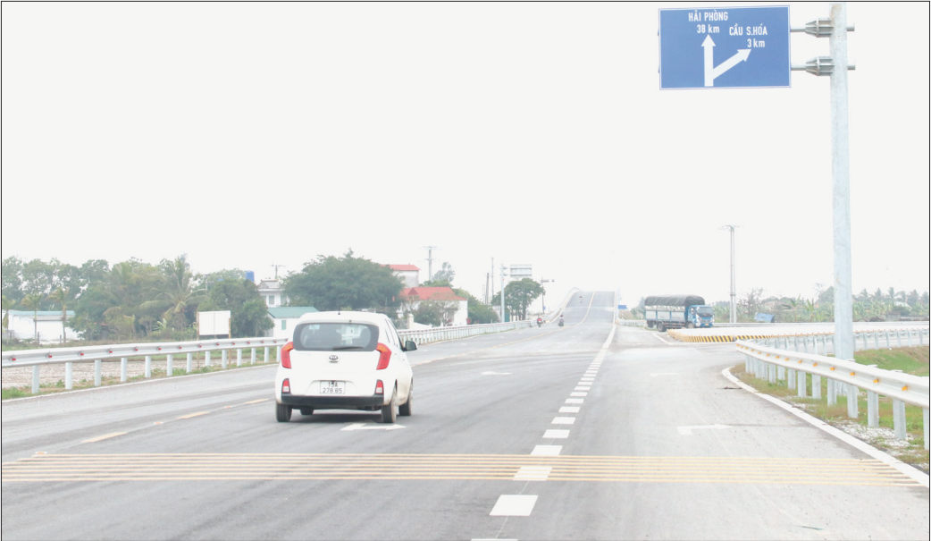
Dự án cải tạo, nâng cấp quốc lộ 37 đoạn qua địa phận tỉnh Thái Bình và cầu sông Hóa hoàn thành góp phần thúc đẩy phát triển kinh tế - xã hội của tỉnh Thái Bình và thành phố Hải Phòng.
