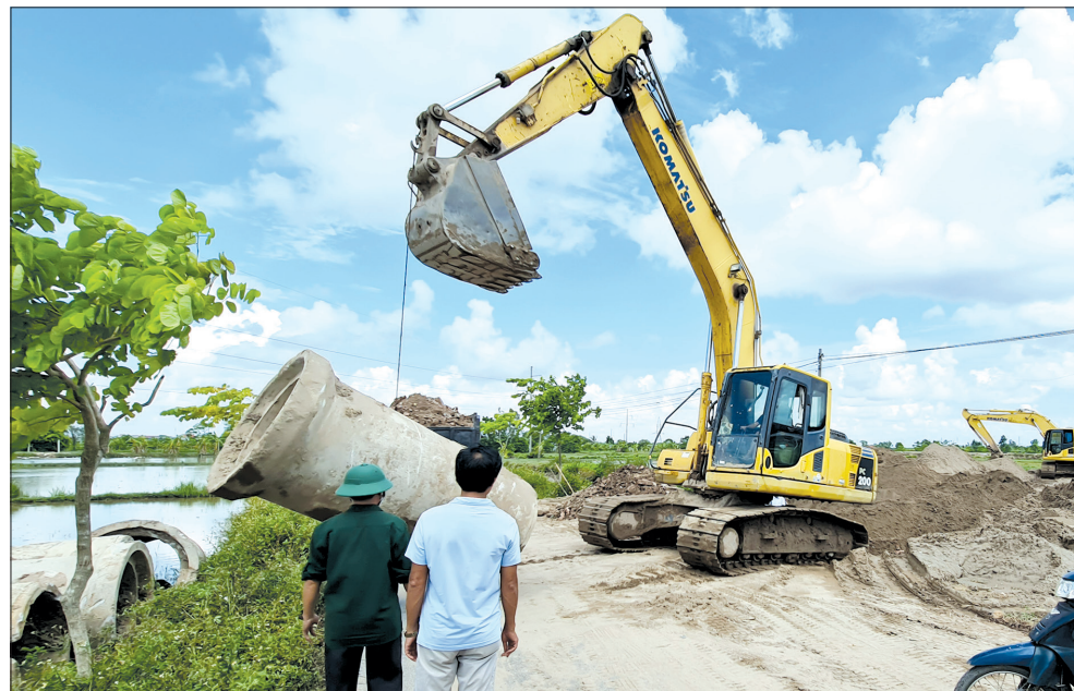
Thi công đường nội bộ trong khu công nghiệp Liên Hà Thái phục vụ dự án của nhà đầu tư thứ cấp Công ty TNHH Greenworks Việt Nam.
