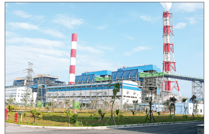
Cùng với dự án nhiệt điện, các dự án điện gió, điện khí đang được đầu tư giúp bảo đảm năng lượng cho công nghiệp của tỉnh phát triển bền vững.
