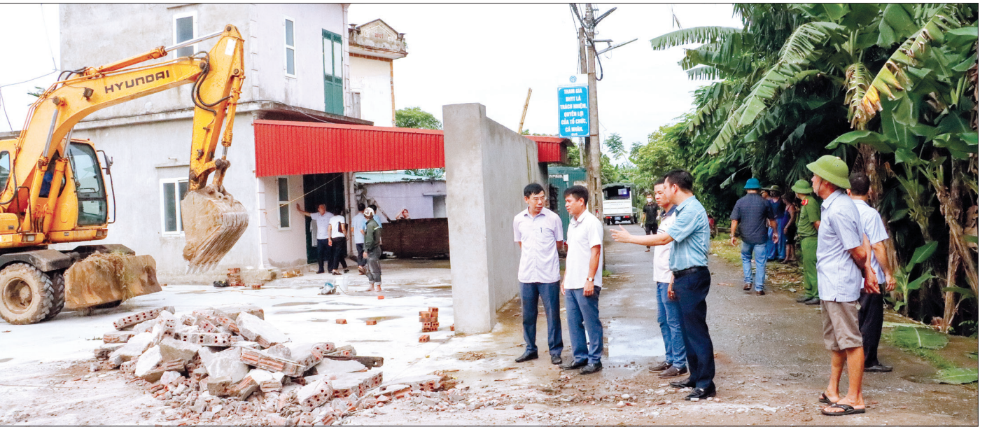
Cưỡng chế phá dỡ công trình xây dựng không đúng quy định tại xã Đông Á.
