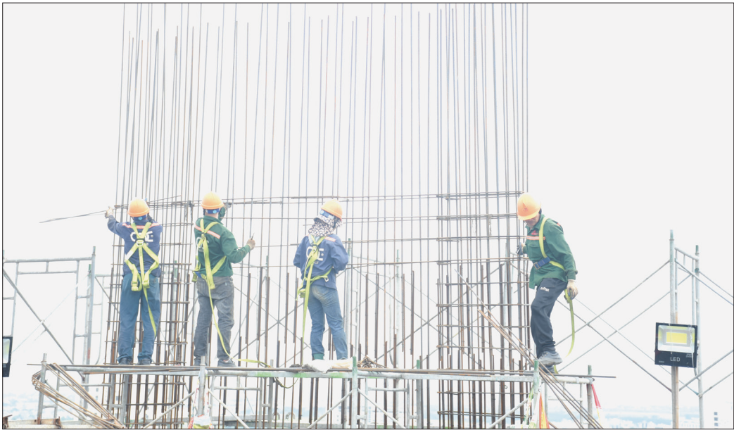
Người lao động được trang bị dây đai thiết bị bảo hộ khi làm việc tại công trình khu nhà ở thương mại Lê Hồng Phong - Eden Garden.
