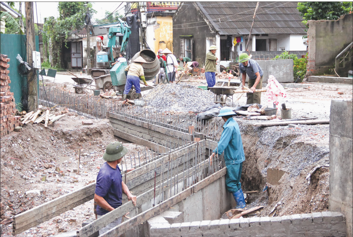
Thi công hệ thống thoát nước đoạn qua địa phận xã Minh Tân (Hưng Hà).
