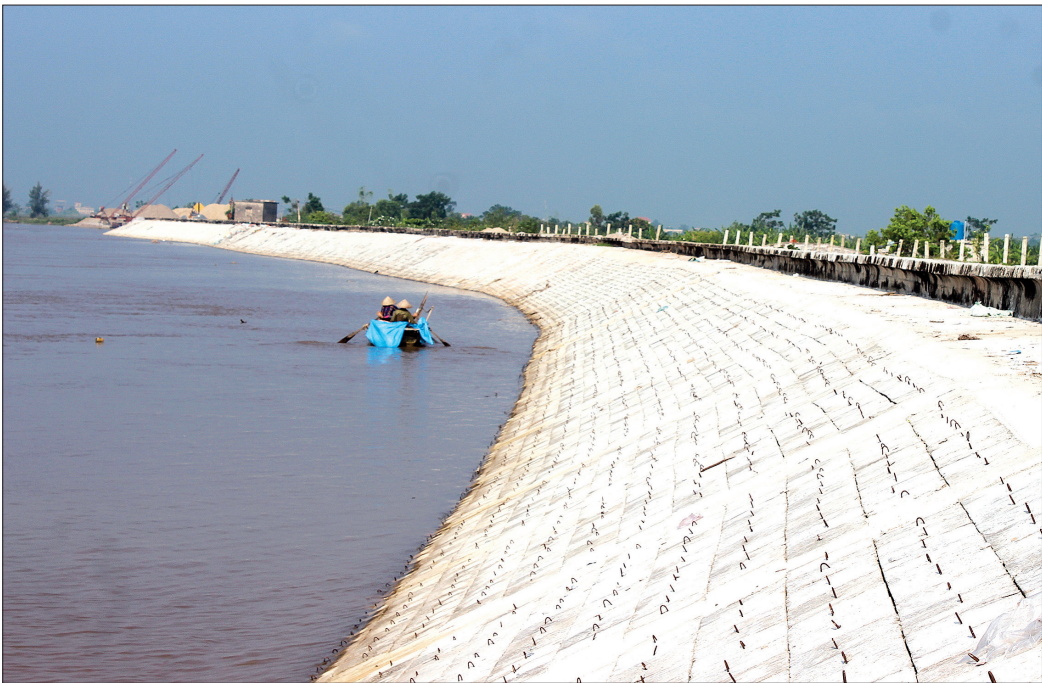
Một số tuyến kè đê sông được huyện Tiền Hải đầu tư xây dựng.
