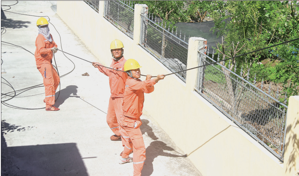
Công nhân Điện lực Tiên Hải làm việc ngoài công trường.
