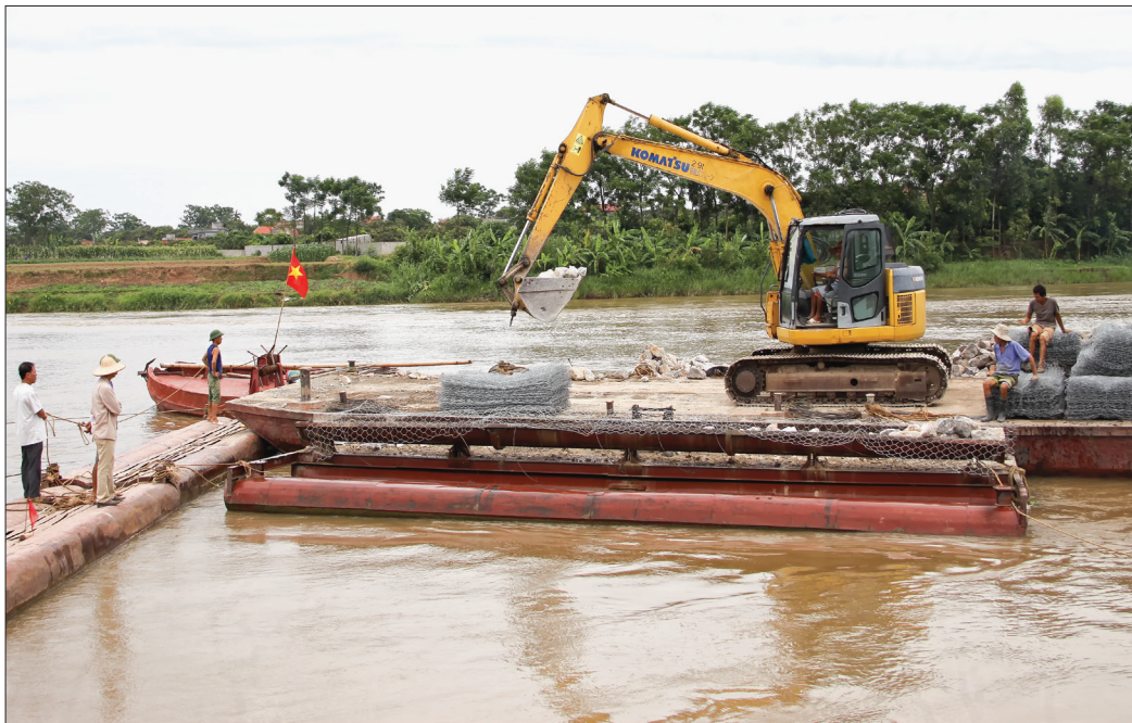
Công ty TNHH Đầu tư xây dựng Thủy Sơn thi công thả rỗng lưới thép lõi đá học công trình xử lý khẩn cấp kè Đào Thành, thuộc địa phận xã Cộng Hòa (Hưng Hà).
