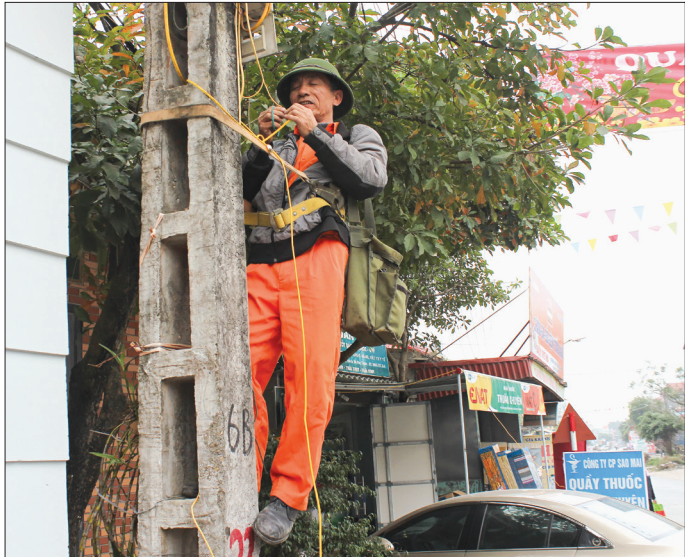
Công nhân Điện lực Thái Thụy xử lý sự cố lưới điện tại xã Thái Thịnh.
