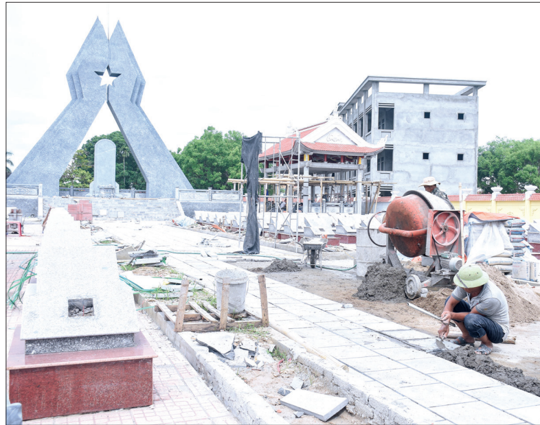
Cụm nghĩa trang liệt sĩ xã Quỳnh Hưng (Quỳnh Phụ) đang được gấp rút hoàn thiện.
