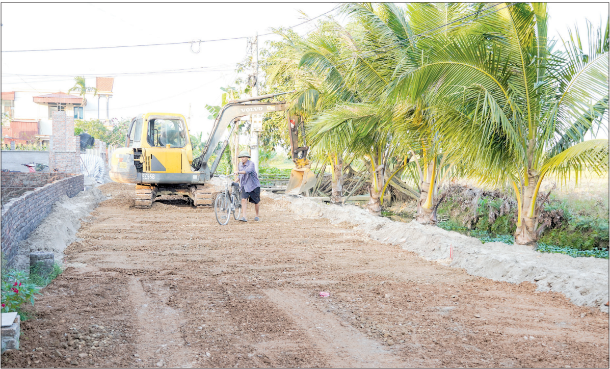
Sau kiến nghị của cử tri thôn Văn Tràng, xã Thụy Văn (Thái Thụy), tháng 11/2024 tuyến đường giao thông vành đai của thôn Văn Tràng được khởi công xây dựng.
