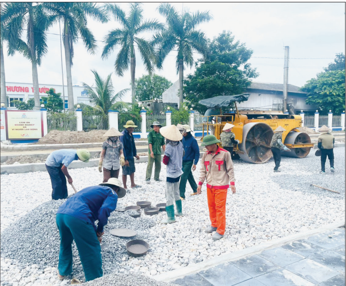
Thị trấn Hưng Hà tập trung nguồn lực đầu tư xây dựng kết cấu hạ tầng.
