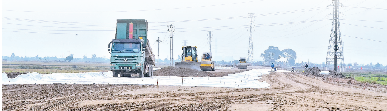
Thi công tuyến đường bộ ven biển.
