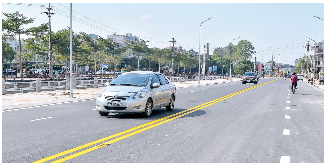
Nút thắt đường Đinh Tiên Hoàng tồn tại nhiều năm nay đã được tháo gỡ.
