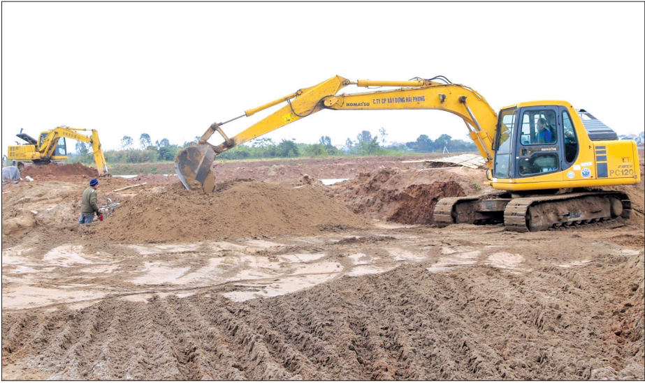
Thi công hạ tầng cụm công nghiệp Hưng Nhân (Hưng Hà).
