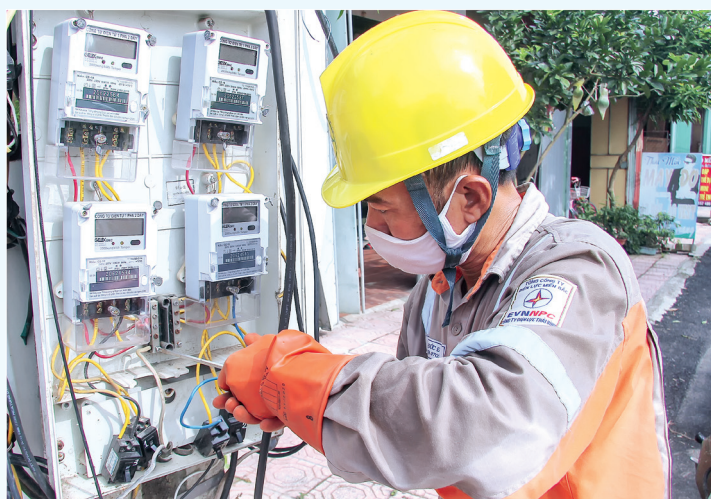
Công nhân Công ty Điện lực Thái Bình lắp công tơ đo xa cho khách hàng.
