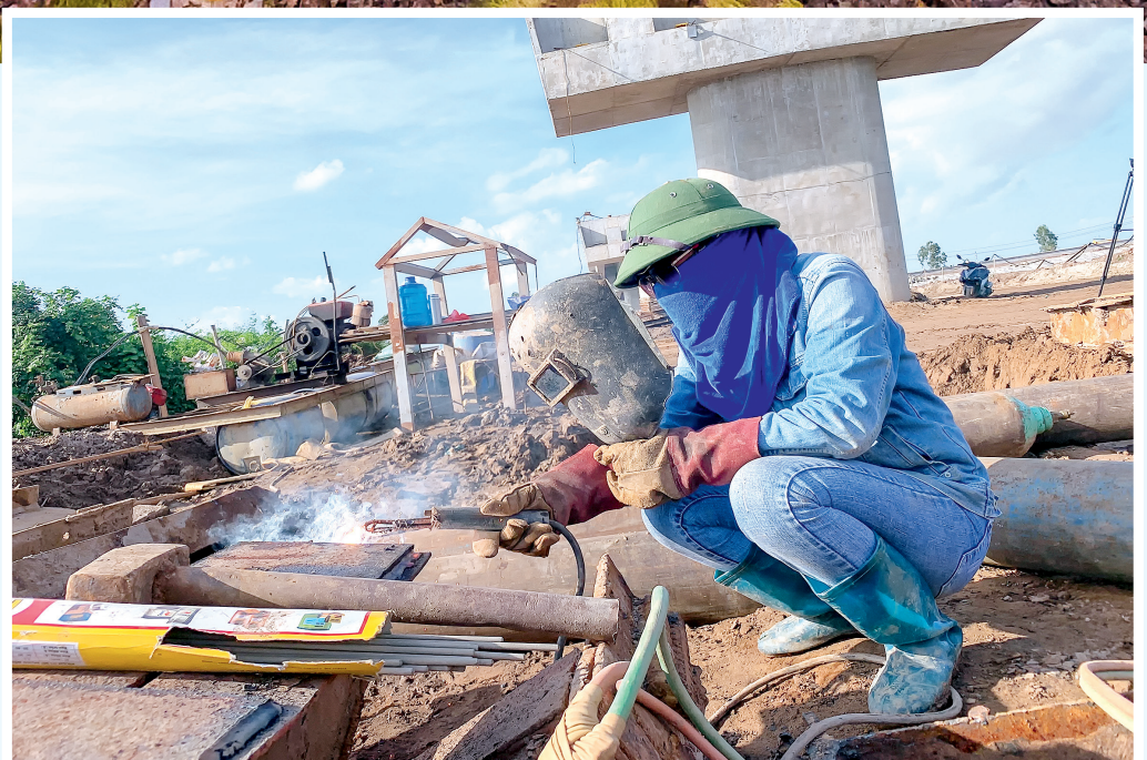
Thi công cầu Diêm Điền.
