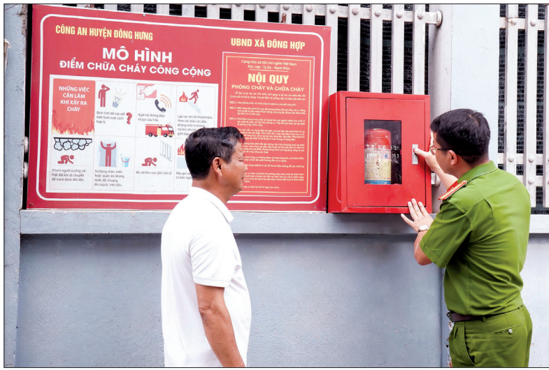
Công an xã Đông Hợp hướng dẫn người dân thực hiện nội quy, quy trình chữa cháy tại điểm chữa cháy công cộng.
