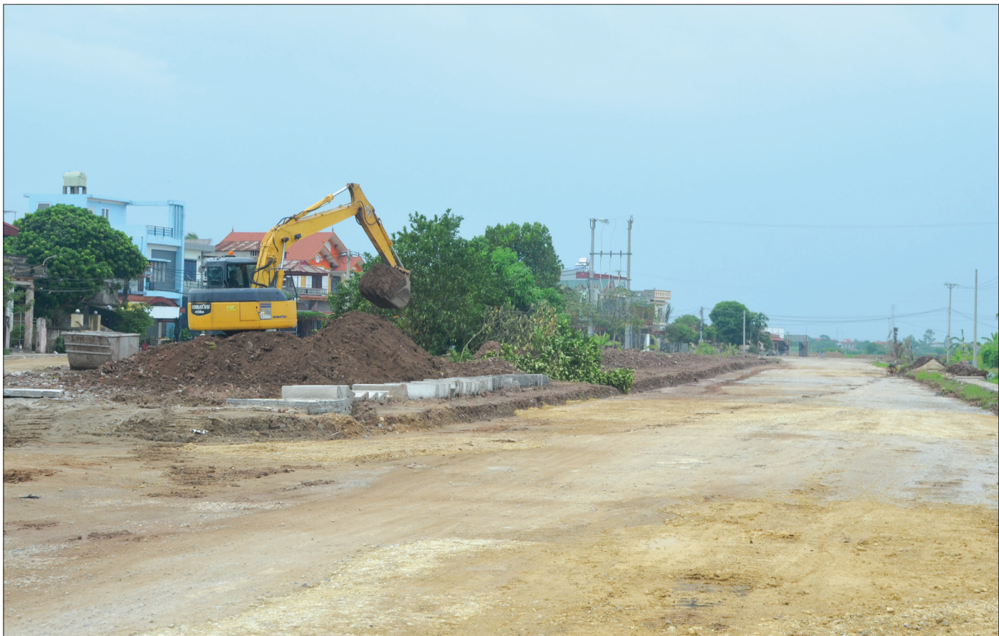
Tuyến đường tỉnh ĐT.452 đoạn qua khu dân cư xã Quỳnh Mỹ (Quỳnh Phụ) phần đầu tháng 10/2024 hoàn thành thăm nhạ.
