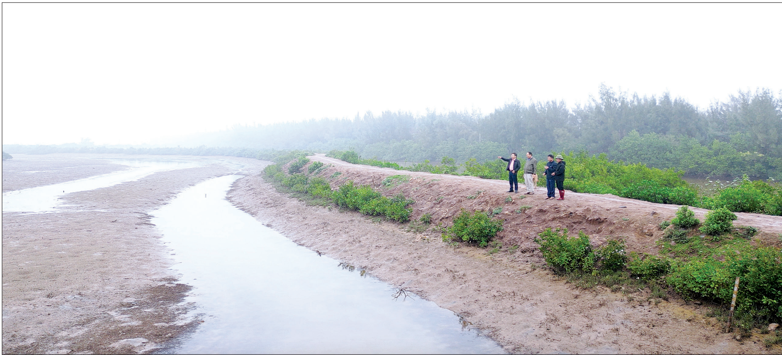
Chính quyền địa phương đang đẩy nhanh tiến độ giải phóng mặt bằng để triển khai dự án.
