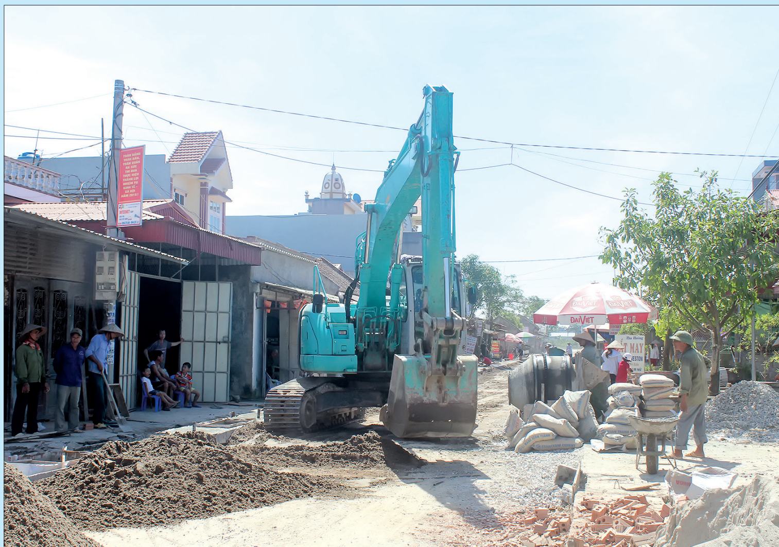
Thi công đường giao thông theo tiêu chí nông thôn mới tại xã Đông Đông (Đông Hưng).
