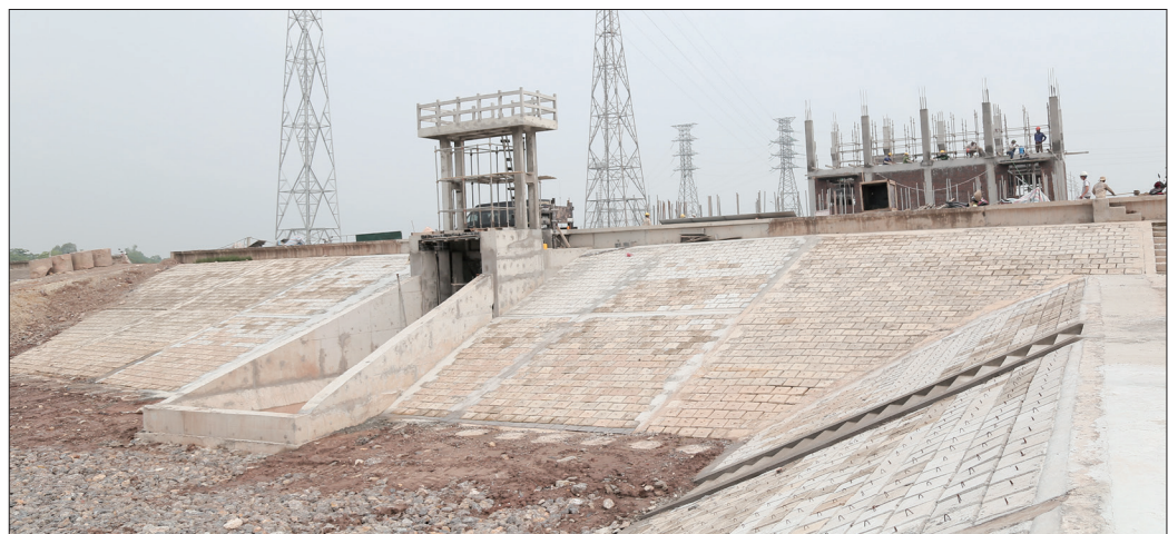
Công trình xây dựng trạm bơm chống ngập Mai Diêm đã cơ bản hoàn thành, đáp ứng yêu cầu phòng, chống thiên tai năm 2024.
