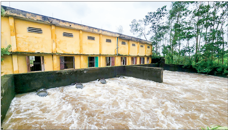
Sáng ngày 8/9, trạm bơm An Quốc (Kiến Xương) vận hành 8/8 máy với tổng công suất 32.000m³/giờ.
