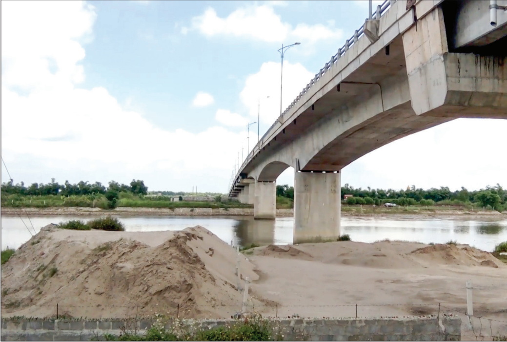
Ông Nguyễn Văn Khiên lập bến bãi tập kết, kinh doanh vật liệu xây dựng vi phạm hành lang bảo vệ đê, thoát lũ.
