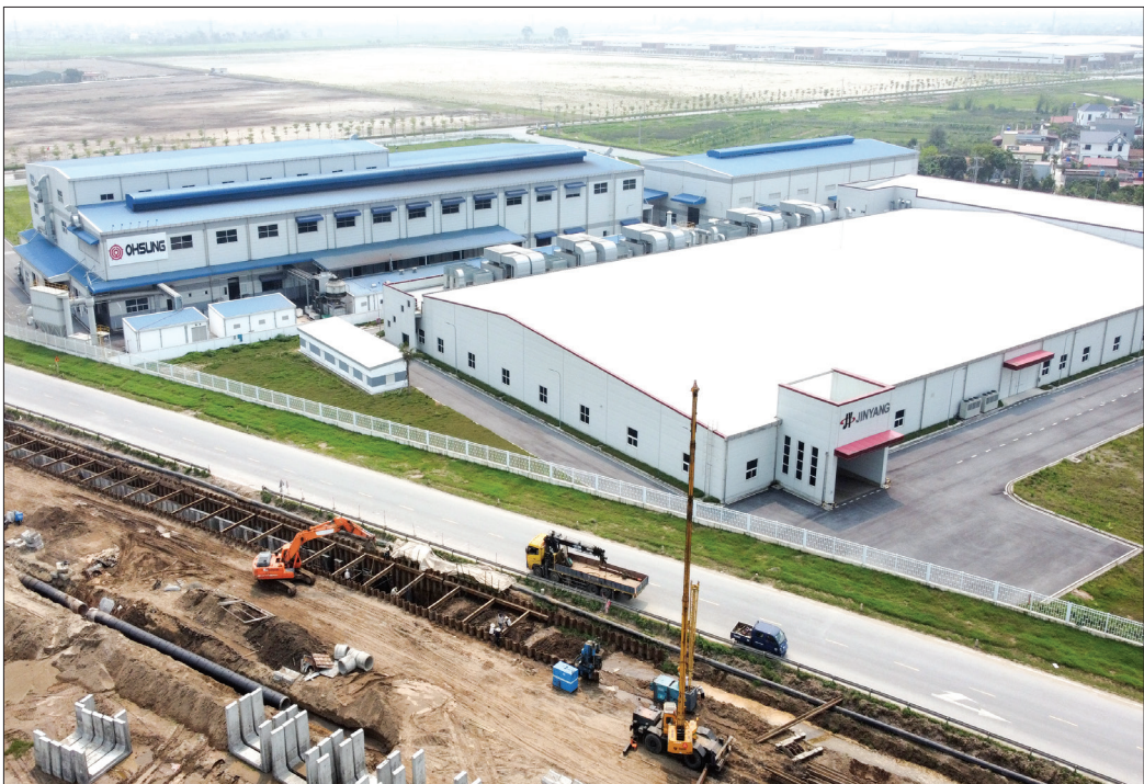
Nhà máy Ohsung Vina Thái Bình chuẩn bị hoàn thành toàn bộ dự án cần khoảng 2.500 lao động phục vụ sản xuất.
