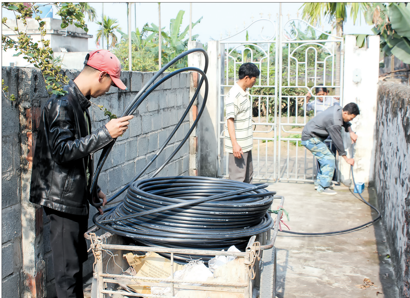
Nhà máy nước sạch Toàn Thịnh triển khai lắp đặt đường ống dẫn nước tới hộ dân xã Thái Thịnh (Thái Thụy).
