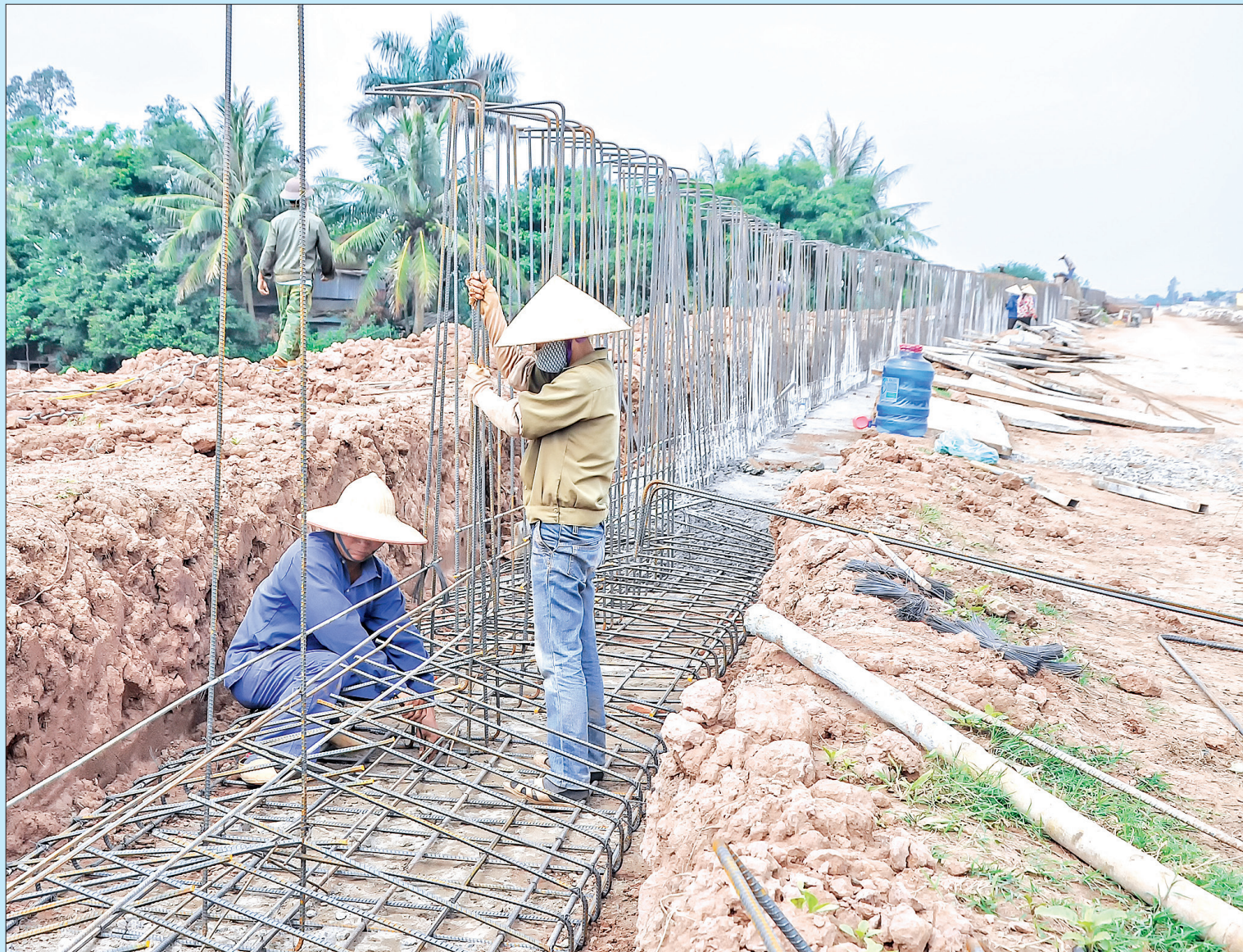
Huyện Thái Thụy đẩy nhanh tiến độ thi công các công trình phục vụ phòng, chống lụt, bão.
