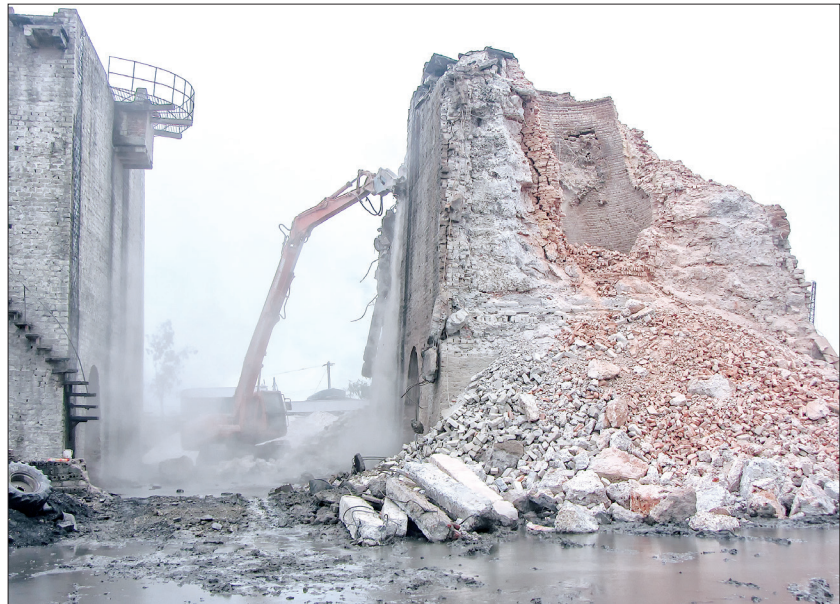
Tháo dỡ lò sản xuất vôi tại khu vực cầu Nghìn, thị trấn An Bài (Quỳnh Phụ).
