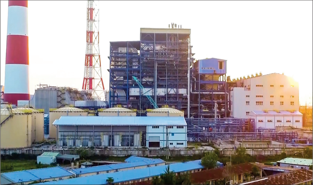
Nhà máy nhiệt điện Thái Bình 1.
