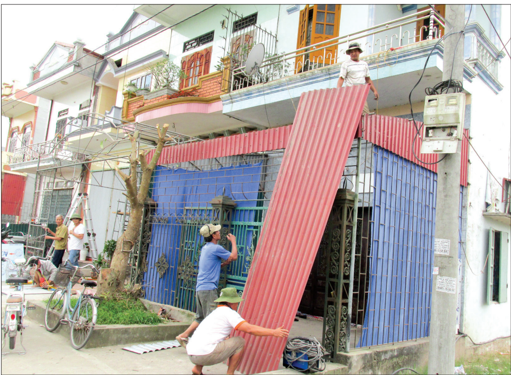
Người dân Quỳnh Hưng (Quỳnh Phụ) tháo dỡ công trình vi phạm hành lang ATGT đường bộ.
