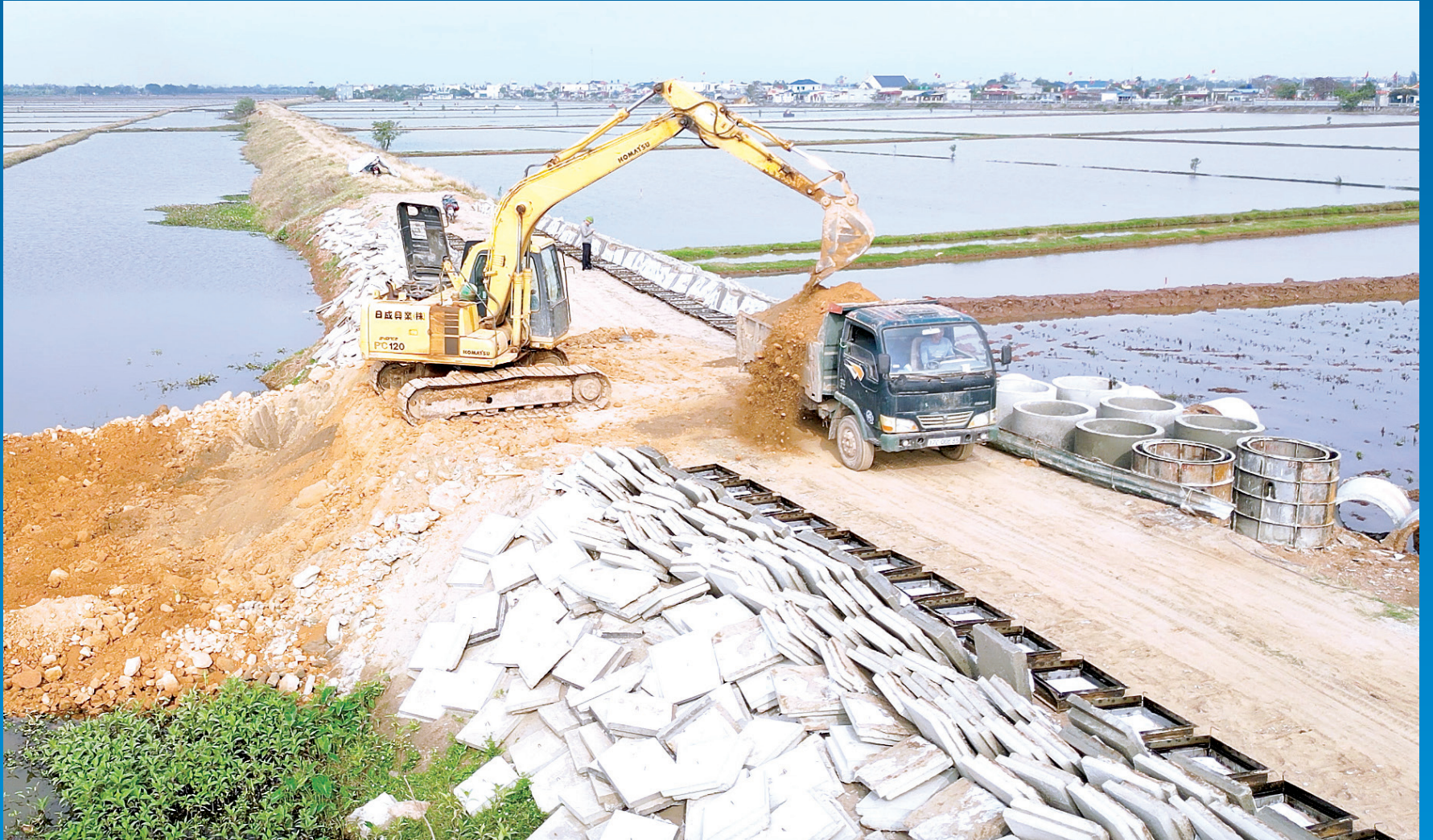
Thi công dự án đê Bình Thanh - Hồng Tiến.
