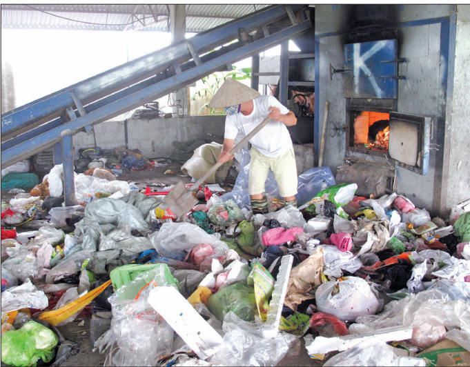
Lò đốt rác thải sinh hoạt xã Minh Khai (Hưng Hà) hoạt động hiệu quả.
