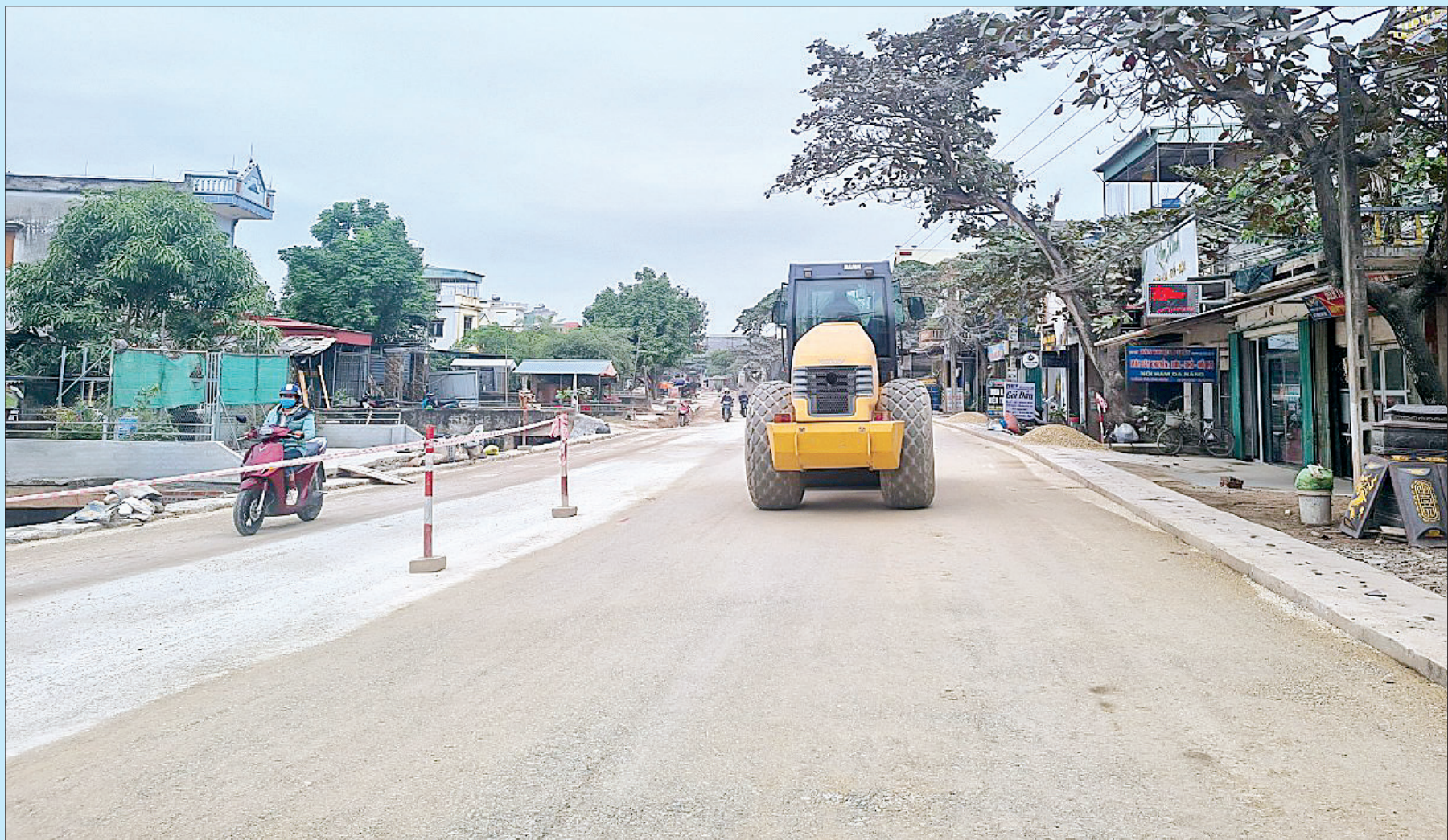
Thi công tuyến đường từ thành phố đi cầu Sa Cao (Vũ Thư).
