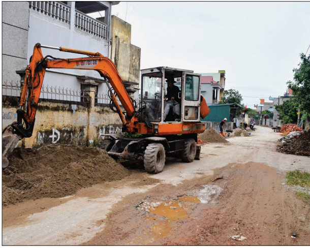
Huyện Quỳnh Phụ hoàn thành giải phóng mặt bằng tuyến đường ĐH 83.
