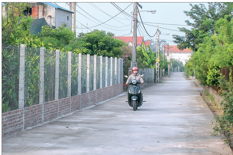
Đường giao thông xã Bách Thuận (Vũ Thư) được cứng hóa và lắp đèn chiếu sáng đáp ứng nhu cầu đi lại của nhân dân.
