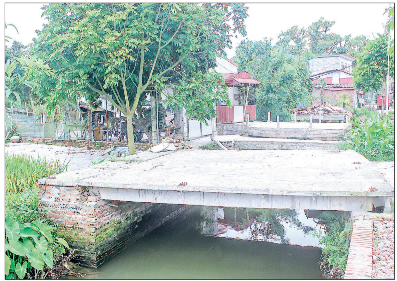
Các công trình xây trái phép trên sông đã được người dân thôn Tân Tiến tự giác tháo dỡ.
