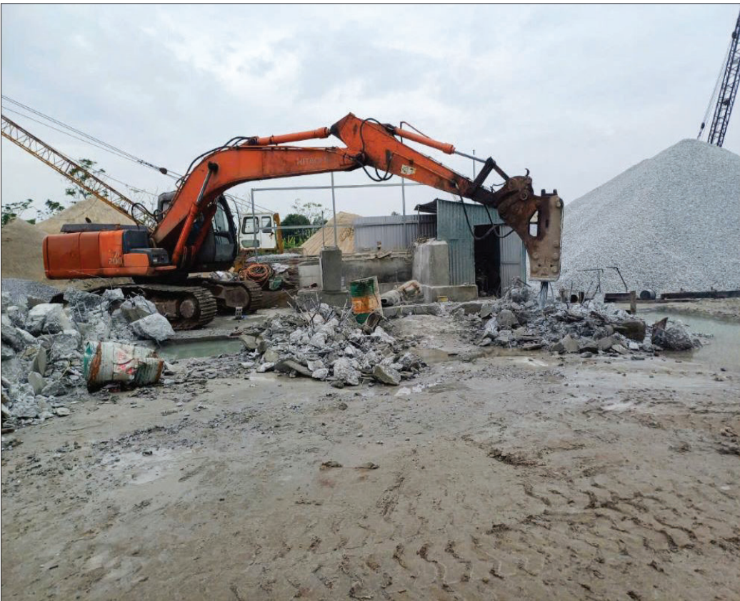
Huyện Vũ Thư huy động lực lượng và phương tiện, phối hợp với chính quyền địa phương hỗ trợ các gia đình tháo dỡ công trình vi phạm.
