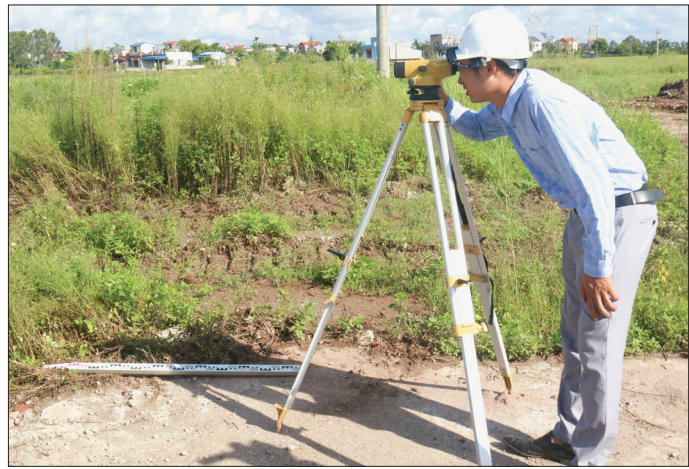
Đo đạc, kiểm đếm diện tích đất đã giải phóng mặt bằng phục vụ xây dựng hạ tầng cụm công nghiệp Hưng Nhân.
