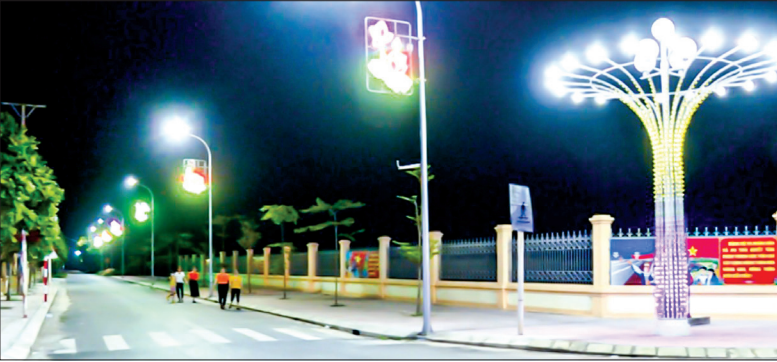
Hệ thống đèn điện “Thắp sáng đường quê” tại xã An Thái (Quỳnh Phụ).
