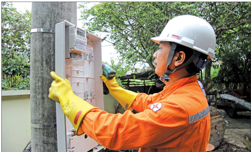
Công nhân Điện lực Quỳnh Phụ lắp đặt công tơ điện tử cho khách hàng.
