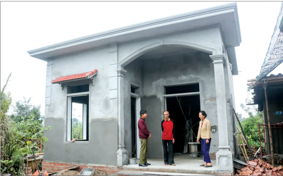
Xây dựng nhà ở cho người có công xã Bách Thuận, huyện Vũ Thư.
