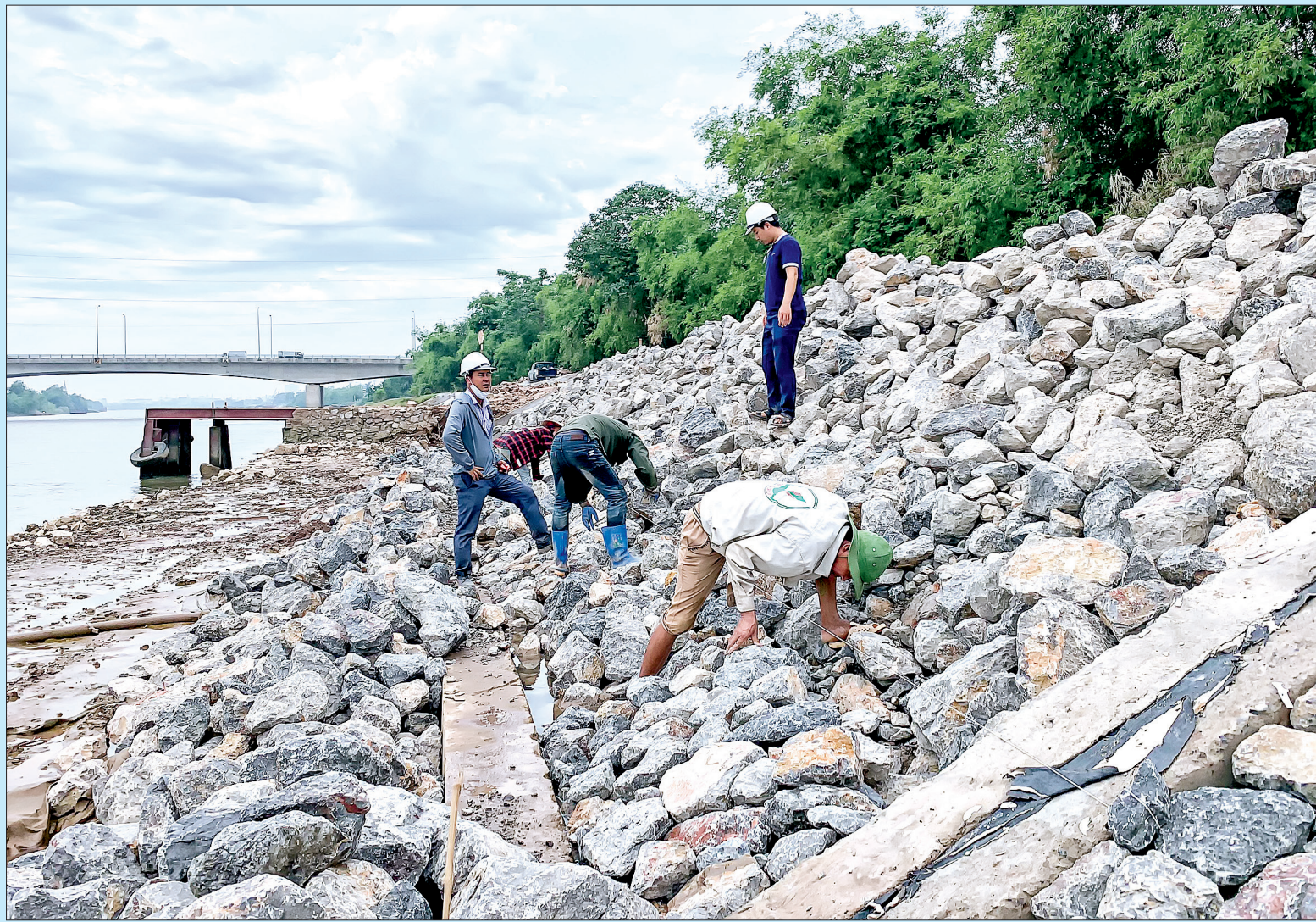
Thi công kè sông Trà Lý đoạn qua địa phận xã Tân Bình, thành phố Thái Bình.
