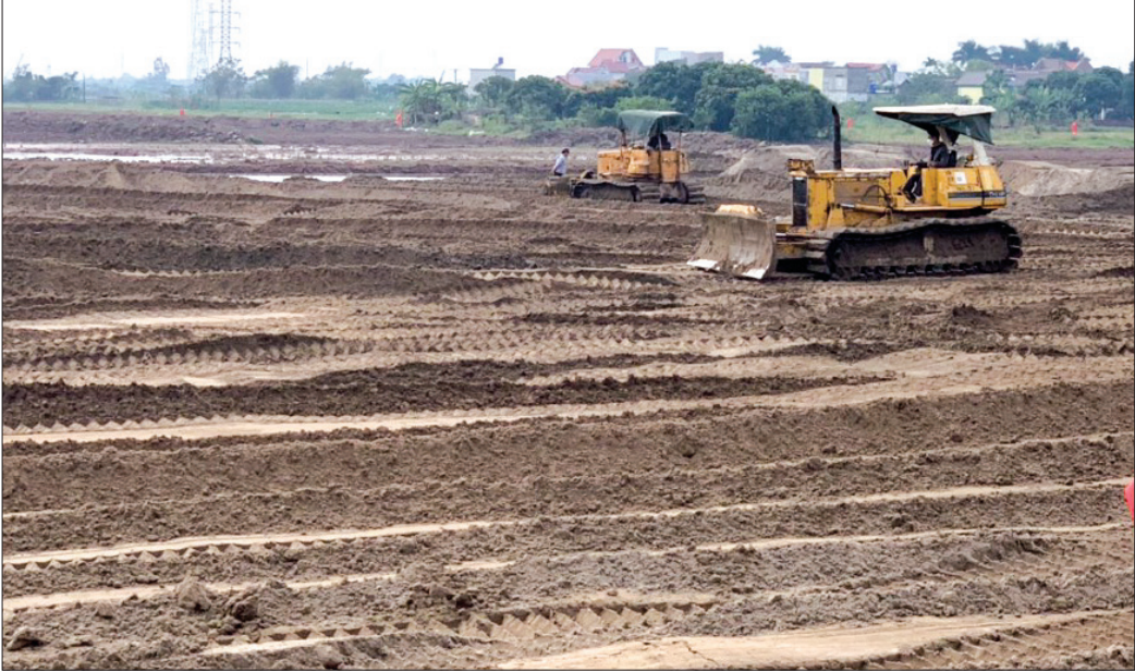
San lấp mặt bằng tại khu công nghiệp Liên Hà Thái.
